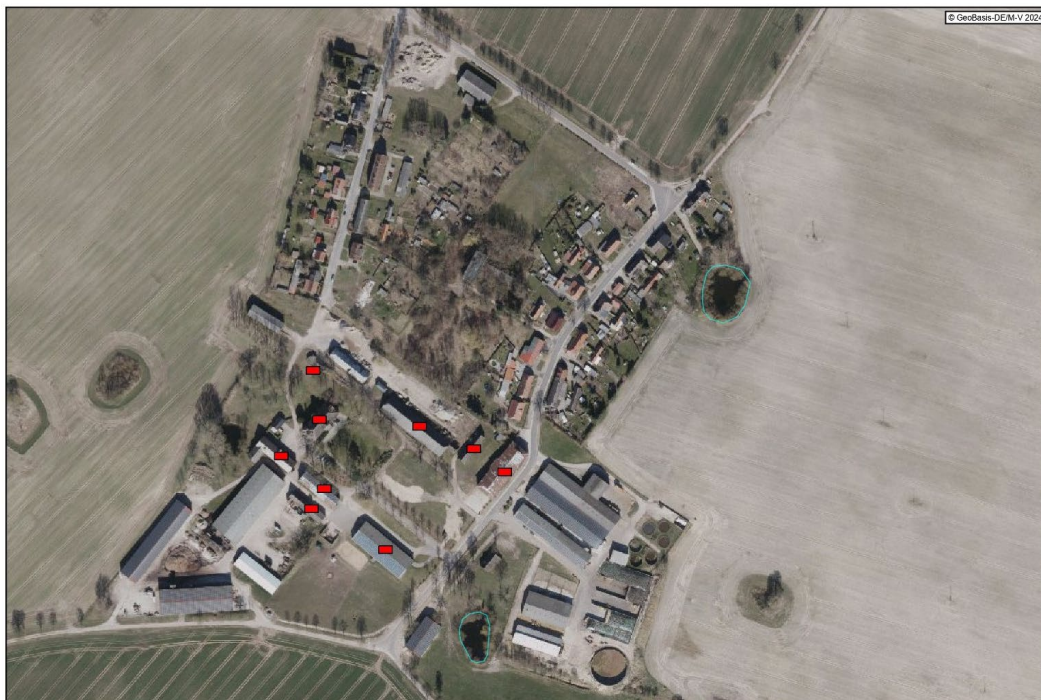
Abbildung 5: Lage der Gebäude der Backsteinroute (rote Rechtecke) im Bezug zu den Satzungsflächen (gelb, ungefähre Bereich) (Quelle: Geoportal MV)
